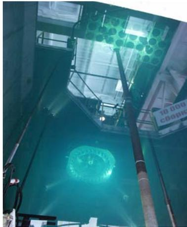
Операция перегрузки и хранение ОТВС производится под слоем очищенной и обессоленной воды не менее 2,5 метров, которая обеспечивает биологическую защиту персонала и окружающей среды от радиационного воздействия, снижает коррозию материала оболочек ТВЭЛов, чехла и обеспечивает теплоотвод.
