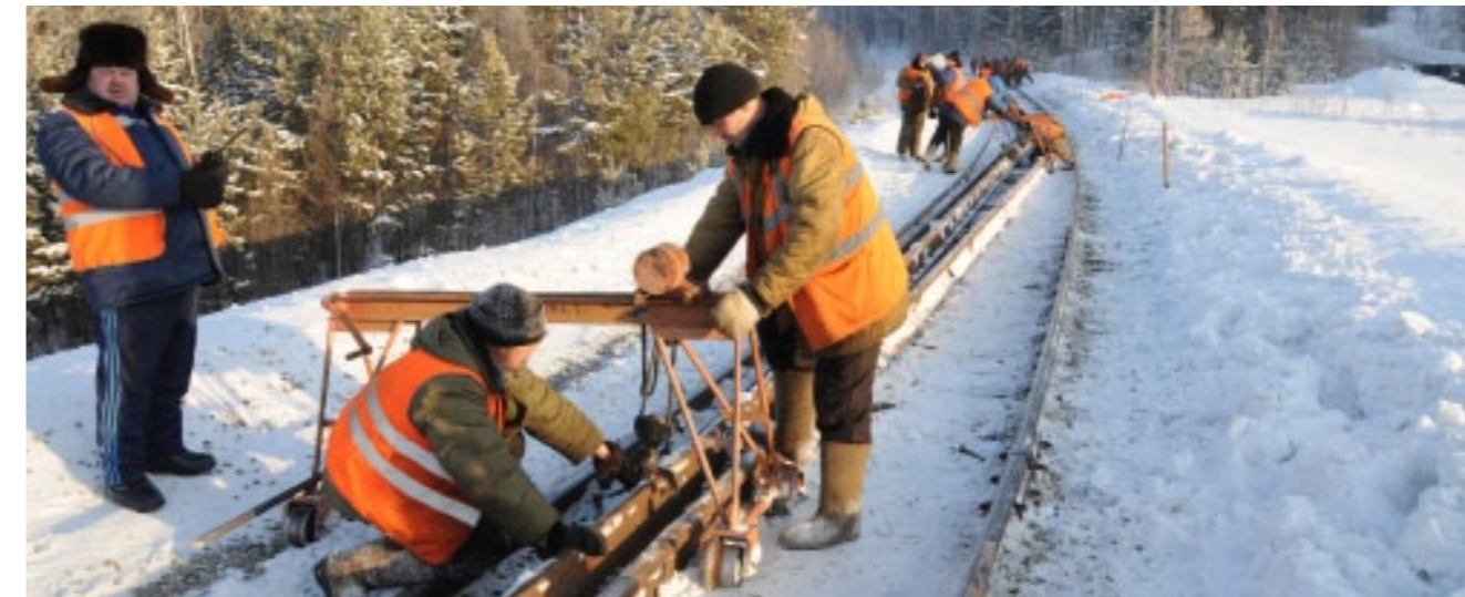
Морозы — ударному труду не помеха! До 50 путейцев одновременно выходили в смену, чтобы в срок выполнить особо важные работы по замене рельсов главного пути на ИХЗ
