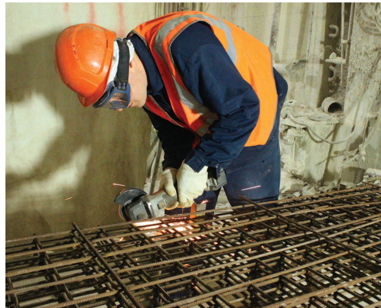
МОНТАЖНИК ТЕХНОЛОГИЧЕСКОГО ОБОРУДОВАНИЯ И СВЯЗАННЫХ С НИМ КОНСТРУКЦИЙ АЛЕКСАНДР ЛУЧЕНКОВ ДЕЛАЕТ АРМОКАРКАСЫ ДЛЯ СТРОИТЕЛЬСТВА ОБЪЕКТОВ ИЗ МОНОЛИТНОГО ЖЕЛЕЗОБЕТОНА
